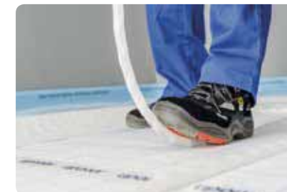
Просто прижмите трубу подошвой к поверхности панели
