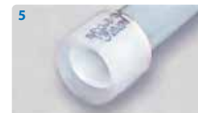
5 Установите кольцо Q&E на конец трубы
